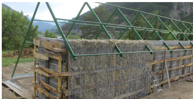
> Isolation extérieure du mur avec remplissage de laine de mouton en vrac et finition en terre crue.
