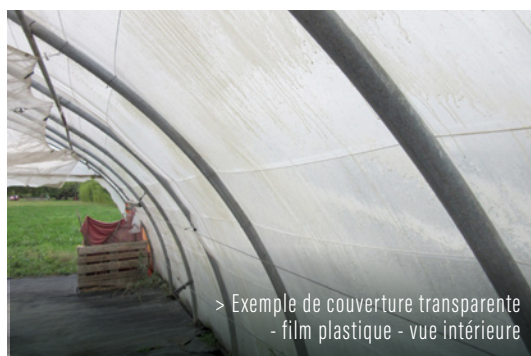
> Exemple de couverture transparente - film plastique
